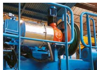
集成安装的电缆卷筒
