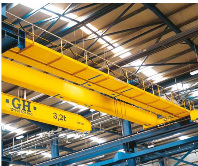
维修走台 小车平台
