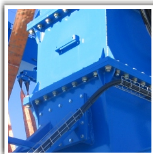
ESTRUCTURA ATORNILLADA FÁCILMENTE DESMONTABLE
