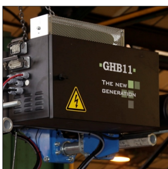
17 Elektrischer Schaltschrank für Seilzug
