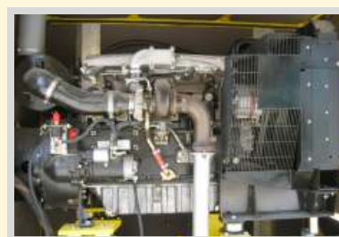
Moteur diesel réfrigéré
