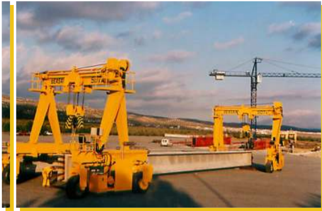
MANUTENTION DE POUTRES EN BETON
