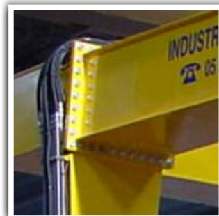
STRUCTURE AVEC ASSEMBLAGE VISSÉ FACILITANT LE DÉMONTAGE
