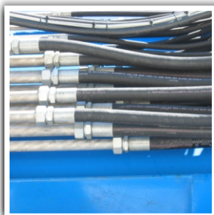
HYDRAULISKE RØR I RUSTFRIT STÅL
